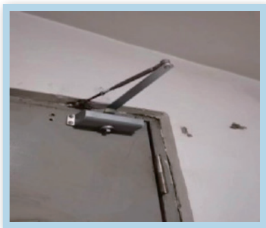
已更換損壞的閉門器
