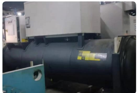
汰換後——為滿足供冷需求，深圳廠區新增磁懸浮離心式製冷機組、方型橫流式冷卻水塔、冷凍水泵等設備，及相應管道、閥門等配件。汰換後的冰機相較于其它冰水機組節電率高達30%以上，進而實現了減碳的效果。
