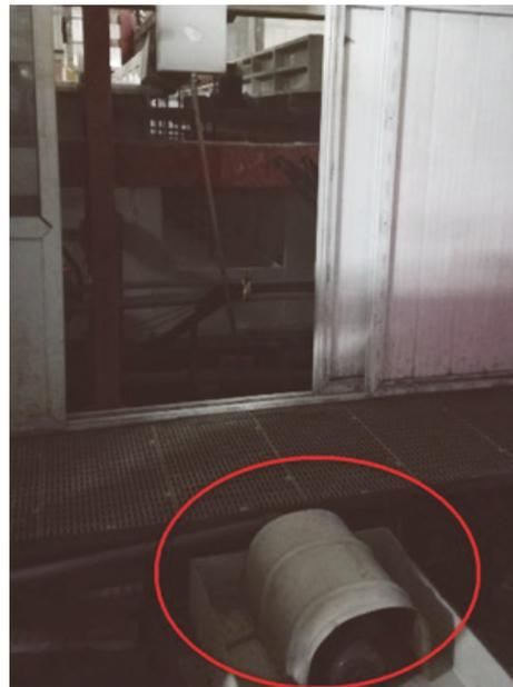
圖：改善後：增加泵浦，鍍回收水洗水回水至鍍槽
