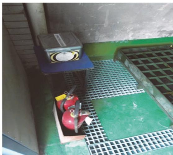
圖：地面硬化及二次防洩漏溝
